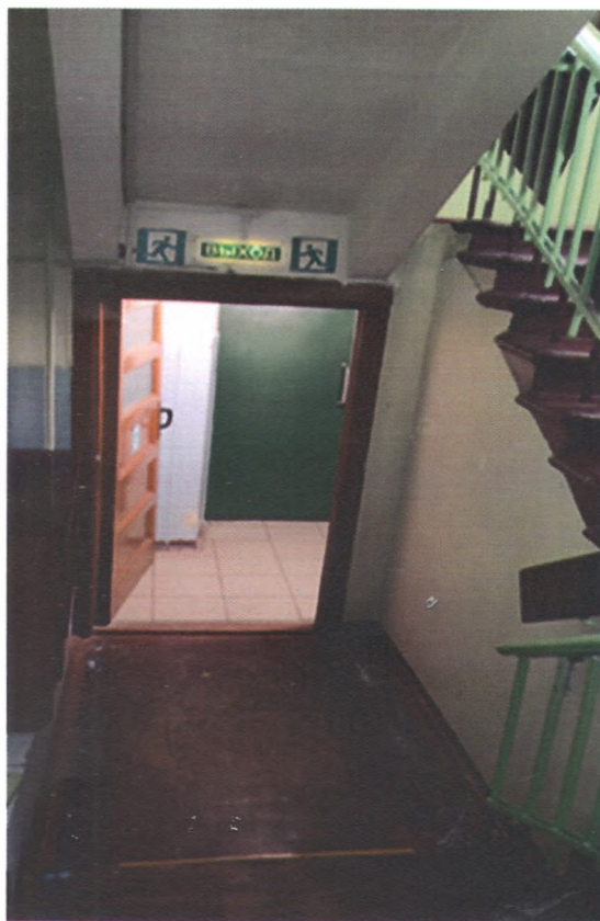
Фото 4 Путь эвакуации на 1 этаже, дверного проема 0,87м
