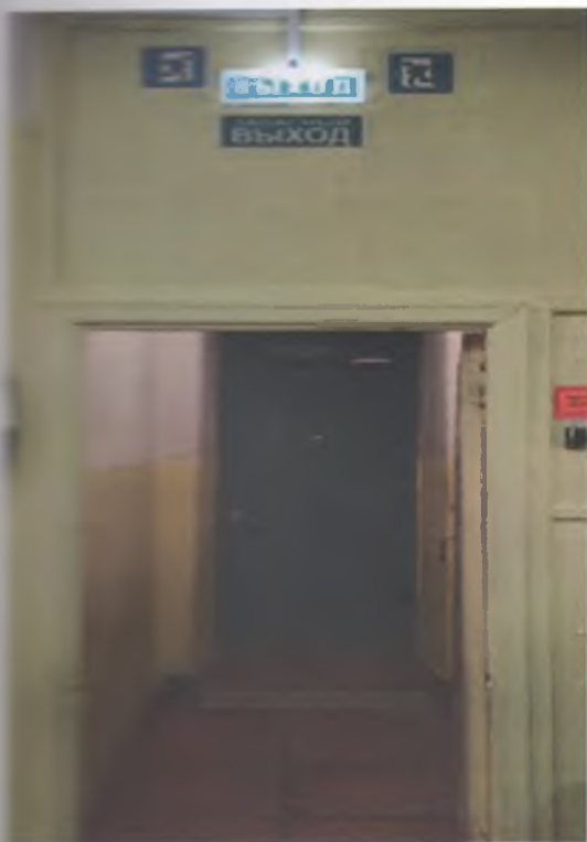
Фото 5 Путь эвакуации на 1 этаже группа ширина 0,87м дверного проема 0,04 см-
